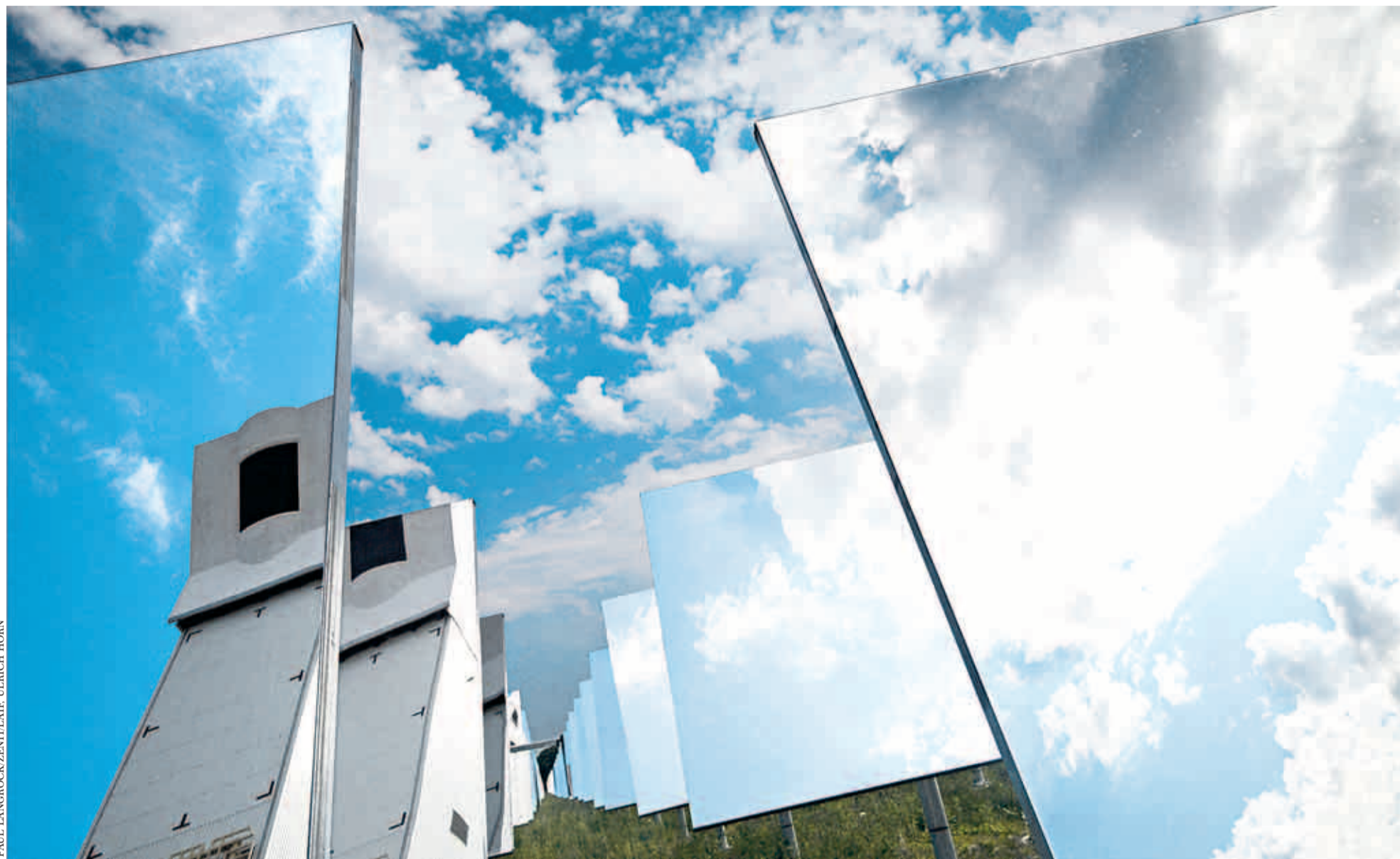
Das solarthermische Versuchskraftwerk in Jülich: Die mit öffentlichen Mitteln geförderte Anlage gilt als Referenzobjekt für kommerzielle Projekte in den Solarmärkten Südeuropas und Afrikas
